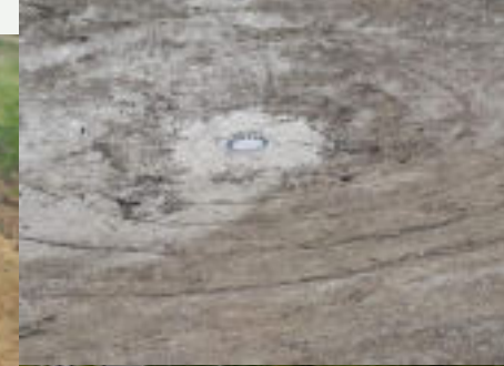
Anlage eines ablassbaren Ortbetongewässers auf einem versiegelten ehemaligen Kraftwerksgelände bei Mumsdorf (Landkreis Altenburger Land)
