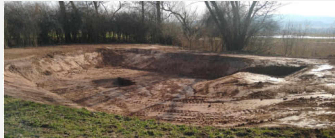
Gebaggerter Tümpel ohne Grundwasser in Aue mit sehr tiefem Grundwasserstand
